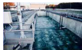
Резервуары с питьевой водой
